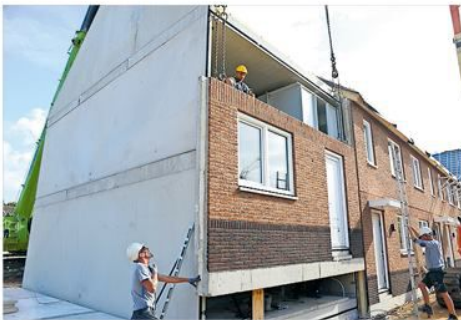
De voorgevel zakt langzaam op z'n plaats.
